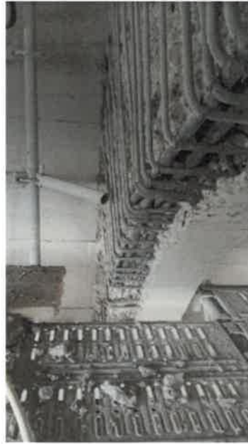
Remplacement d'armatures de béton armé
