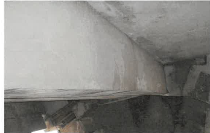
Ragréage de parement en béton et protection par revêtement LHM
